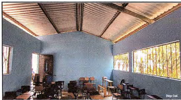
Foto 4: En esta fotografía se observar el mejoramiento del módulo III, se repelló la pared y también se procedió a pintar.
