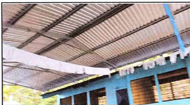
Foto 3: Así se observa el cambio de entecha del corredor de la escuela donde las láminas sustituidas se encontraban en pésimas condiciones.
