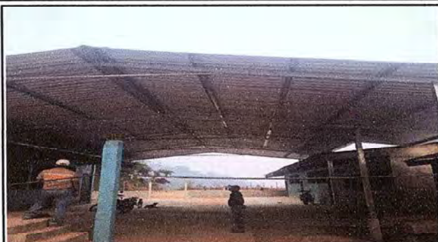
Foto 1: En esta imagen se observa la culminación del entechado del corredor y al fondo se observa la circulación de la escuela.
